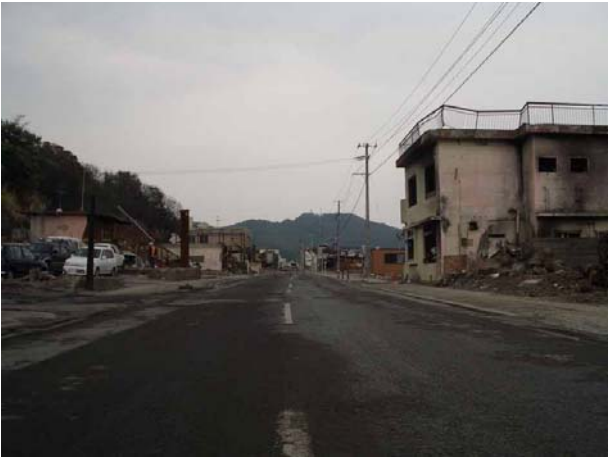
道路の土砂は取り除かれている
