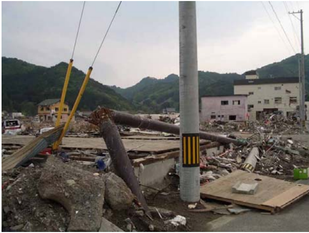
電柱が急ピッチで復旧されている
