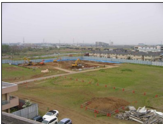
▲清化園解体後(2011年4月)
