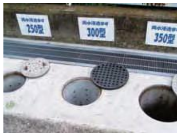
雨水浸透ます設置モデル
