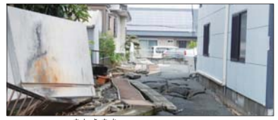
▲熊本県益城町内の被害状況。(撮影：国立市職員)
