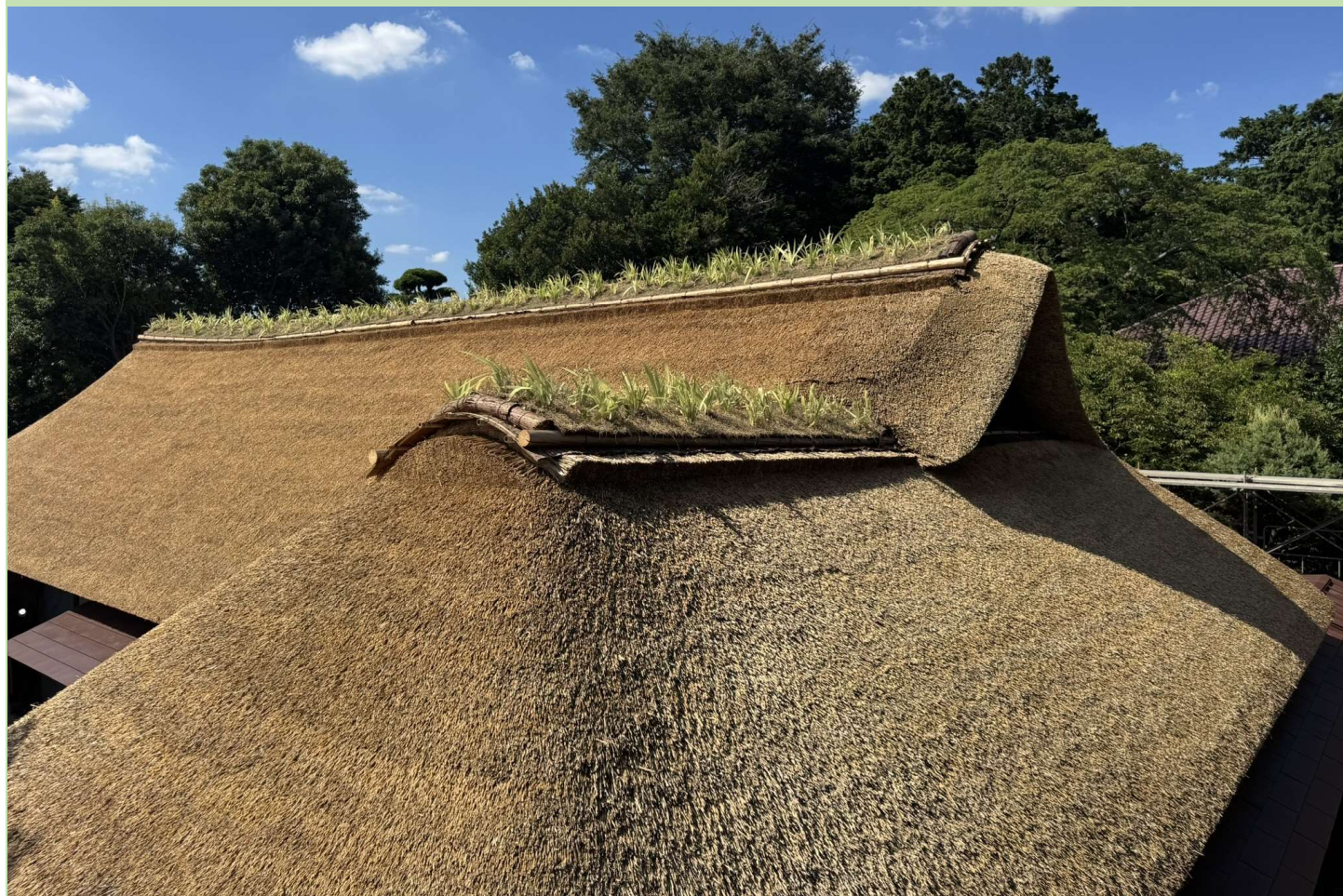
(復原工事) 茅葺き屋根施工完了
