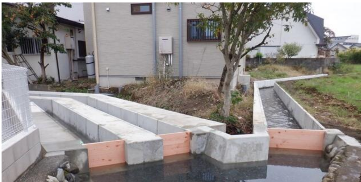
【令和 6 年度用水路改修工事（その 1）】
