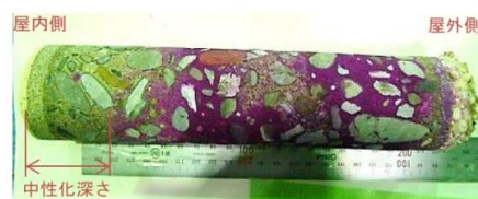
コンクリートの中性化深さ
