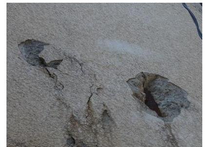
鉄筋が錆びて膨張し、コンクリートが爆裂している。剥落の危険あり。
