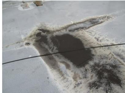
経年による防水層の摩耗。雨漏りの原因となる。
