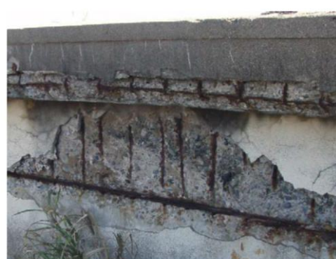
写真 3 塩害による鉄筋の腐食
