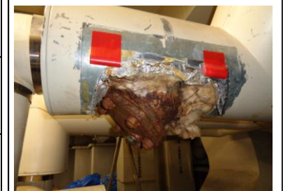
機械室 空調配管の発錆
