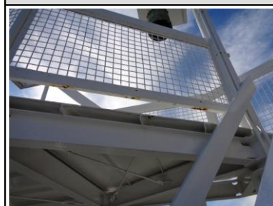
階段 上裏塗膜剥離
