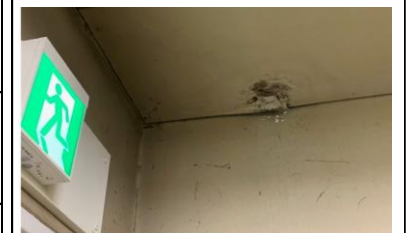
男子ロッカー室 天井破損
