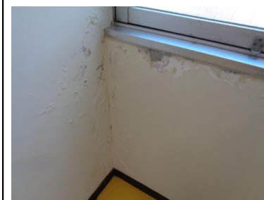
内部壁 建具廻りに塗膜膨れ・剥がれ・錆汁
