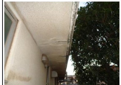
庇軒裏 コンクリート欠落
