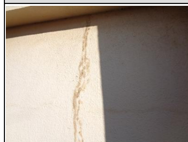
外壁 補修跡劣化
