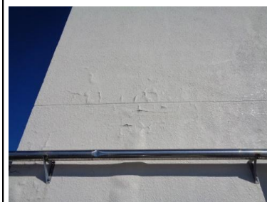
外壁 塗膜膨れ・ひび割れ
