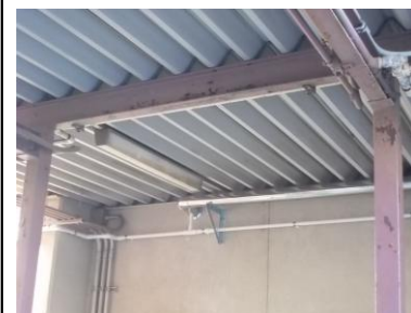
渡り廊下 塗膜剥離、発錆
