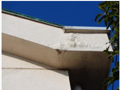
軒裏破風廻り 剥離、ひび割れ
