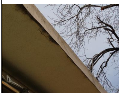
庇 ひび割れ、雨漏れ
