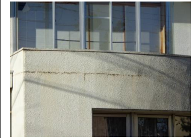
南側外壁 ひび割れ・錆汁
