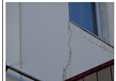
外壁 ひび割れ・錆汁
