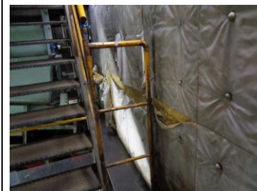
内部壁 劣化、断熱材剥がれ
