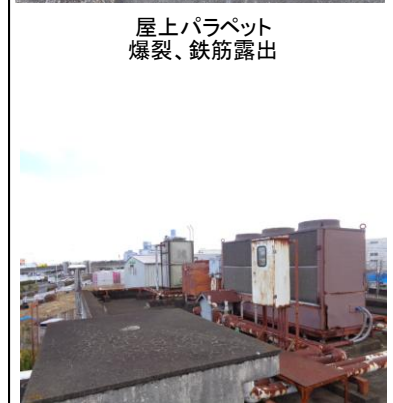
空調機器 使用していない機器の発錆
