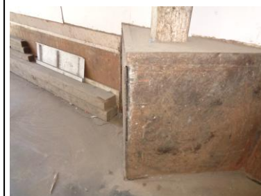
内部柱防護版 発錆、浮き
