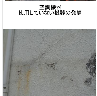
外壁 ひび割れ、塗装剥がれ、錆汁
