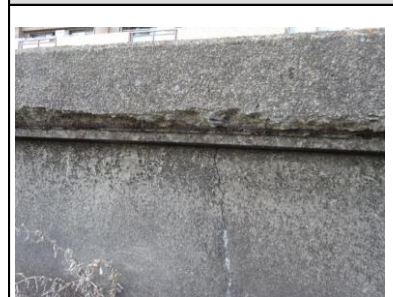
屋上パラペット 爆裂、鉄筋露出
