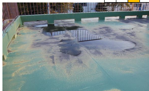
排水不良 と随所に 変質 が見られる。
