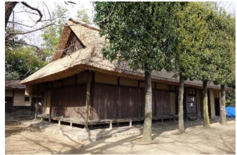
▲茅葺屋根葺き替え後の古民家
