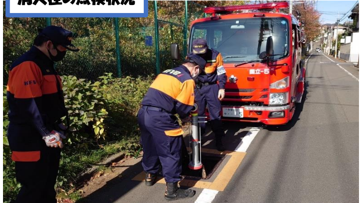
消火栓の点検状況
