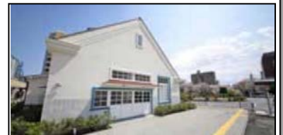
▲DECK周辺の写真。
