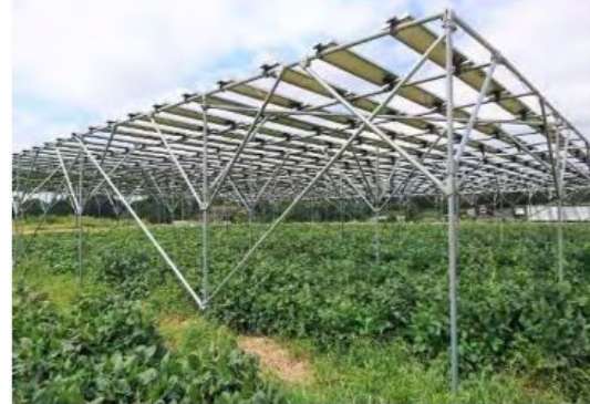
発電設備の外観
