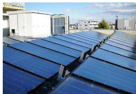
中央図書館に導入されている次世代新型空調の太陽熱パネル
