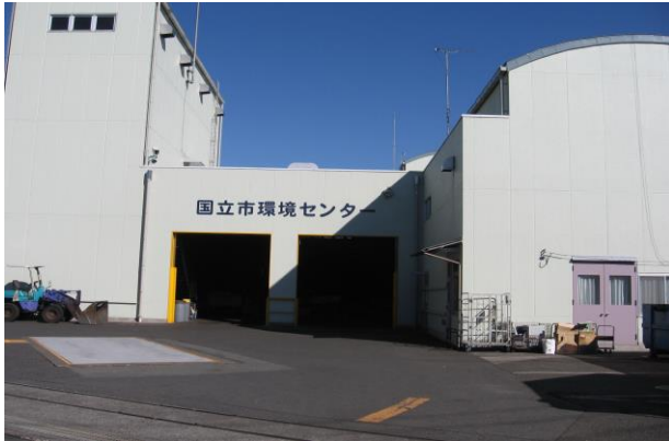
環境センター（全景）
