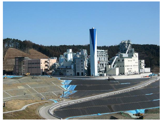
エコセメント化施設
