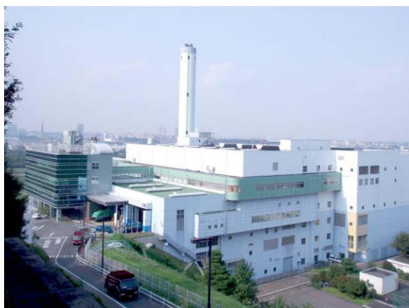
クリーンセンター多摩川（全景）
