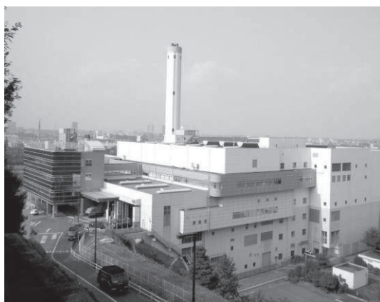
クリーンセンター多摩川（全景）
