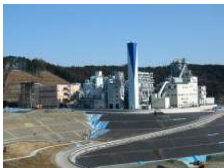
エコセメント化施設
