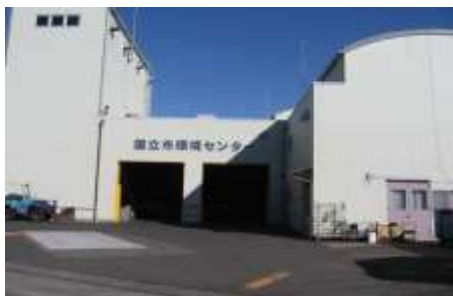
環境センター（全景）
