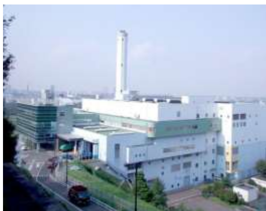
クリーンセンター多摩川（全景）
