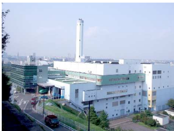
クリーンセンター多摩川 (全景)
