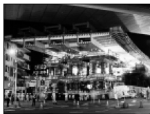
図-4 板橋相生陸橋：架設状況
