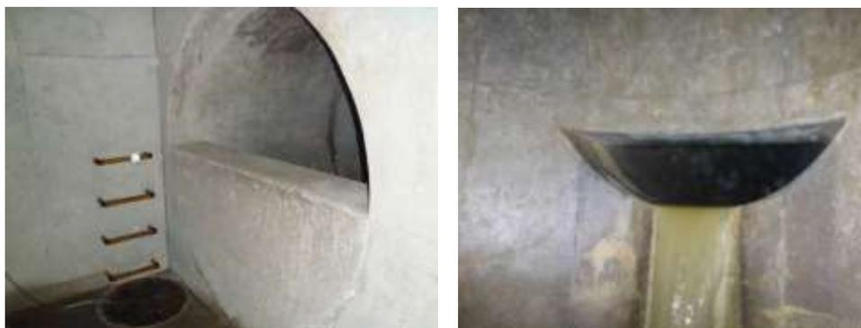
図 5-9 流下貯留管と分岐するφ1800mm 管渠の上流部、下流オリフィス部
