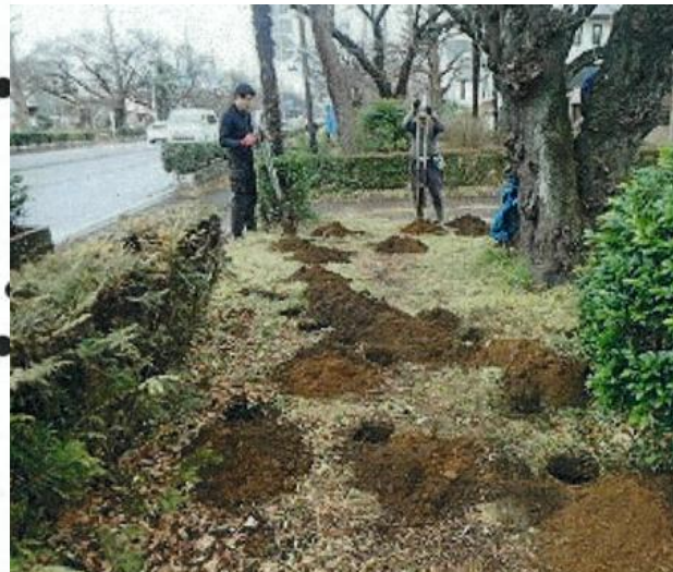
ダブルスコップによる掘削
