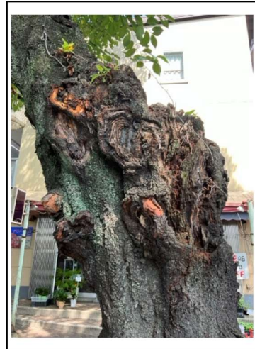
幹の腐朽(車両接触痕)
