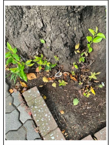
鋼棒貫入異常
