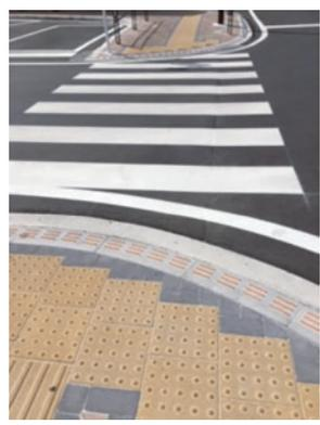
図 16 歩道と車道の段差解消
