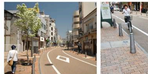
歩車道段差はなく、円形側溝のグレーチングのみで見切っている
