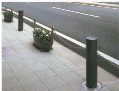
郡山市 郡山駅前周辺(埋没式)
