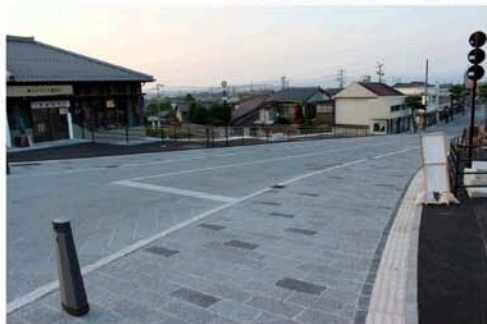
事例(3) 出雲市神門通り 幅5mの車道と路側帯(歩道)を段差のない同一素材で仕上げ、道路を広く見せることに成功している。場所によっては部分的にポラードを設置することで安全性を確保する。
