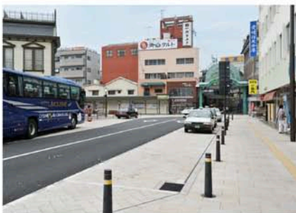
歩道と車道(タクシーベイ)の段差もフルフラットとなっている
