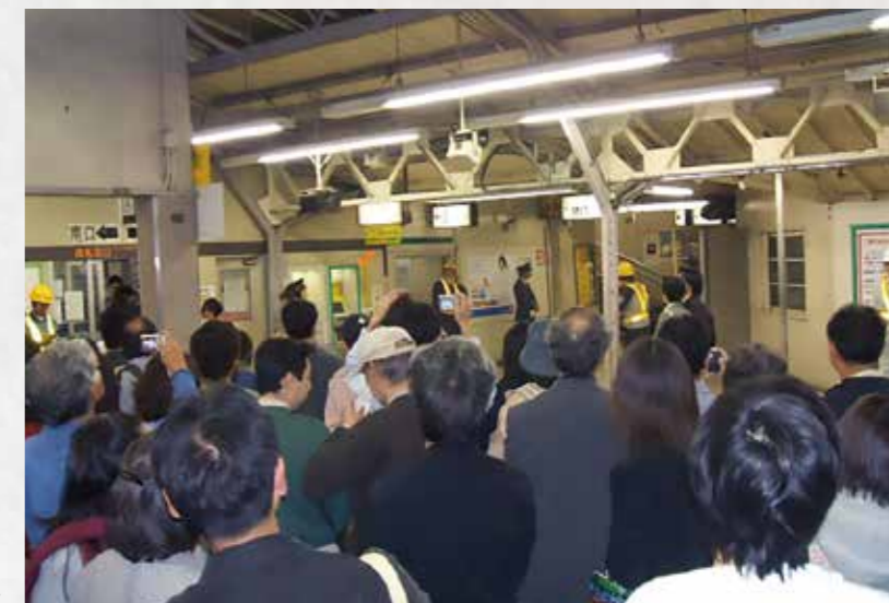
旧国立駅舎解体直前の様子
