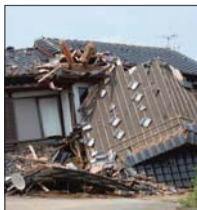
▲熊本地震で倒壊した家屋。
