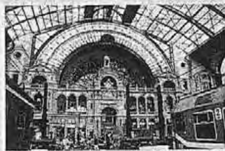
ベルギー、アントワープ駅。デッドエンドの終着駅においてホーム機能も駅舎と一体となった伝統的で豊かな駅空間
