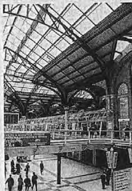
イギリス、リバプール・ストリート駅。鉄筋の骨柱、床による豊かな大空間に、新しくガラスのチューブ状のペデストリアンデッキが設けられ、より立体的なアトリウム空間を構成している
