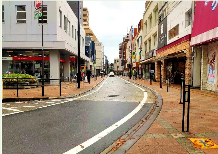
▲整備完了後の北1号線（北口駅前商店街沿い）
