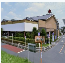
温浴施設の外観写真 （敷地南東：河川敷側より）
