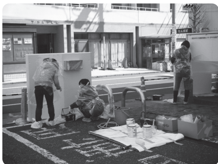
施設利用者との塗裝修繕
