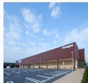
複合商業施設の外観写真 (いずみ大通り側より)
