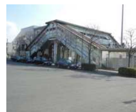
谷保駅跨線橋
