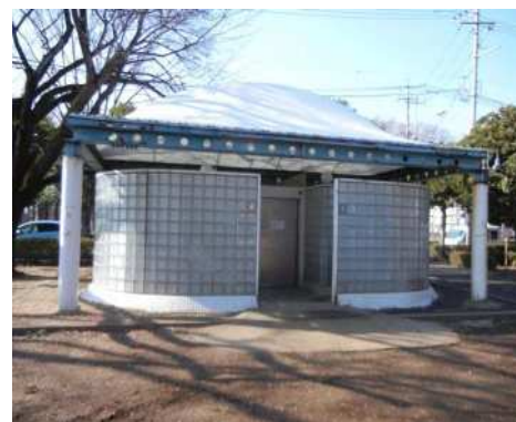
谷保第四公園公衆便所
