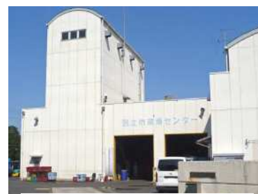
環境センター（処理棟）
