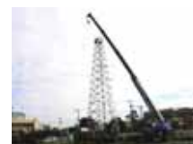
(水戸掘削工事用やぐら写真)
