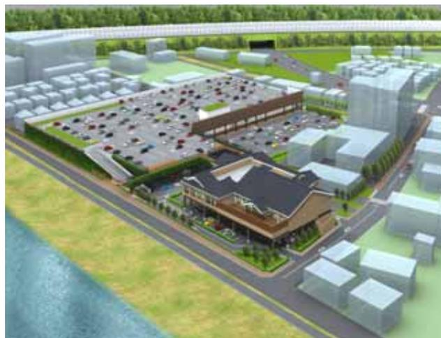
計画では、(仮称)国立温泉 湯楽の里は、上の鳥かん図のように多摩川に面してピロティ形式(1階を柱だけ残し、2階以上建物を建設する様式)で建設されます。
