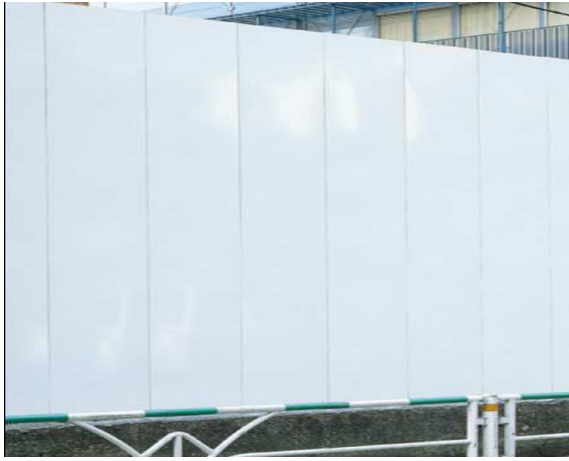
例：成形板による仮囲い(工事現場周囲に設置)
