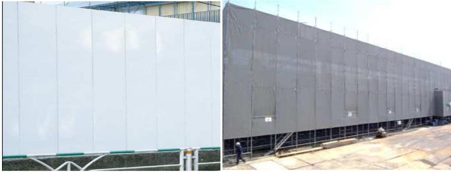
例： 成形板による仮囲い（工事現場周囲に設置）
