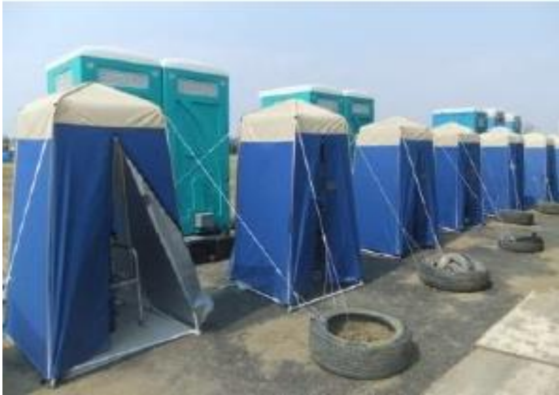
マンホールトイレ
