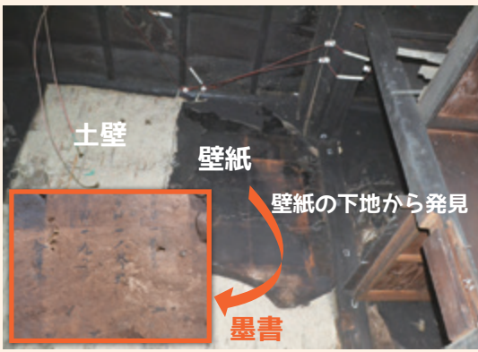
▲中2階解体のようす
