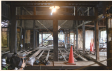
▲解体中の西側からみた大黒柱
