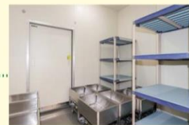
④プレハブ冷蔵庫 1,200 kgの野菜を冷蔵保管することができます。
