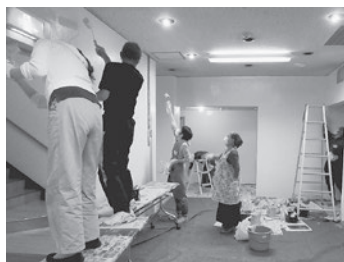
地下廊下が明るくなりました！
