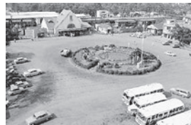
↓たましん階上から見た 国立駅南口広場 1964年
