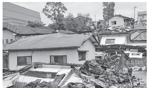
熊本地震で倒壊した家屋 (4月下旬)
