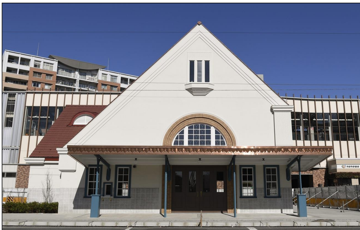
▲再築工事中の「旧国立駅舎」(令和2年(2020年)2月撮影)。
